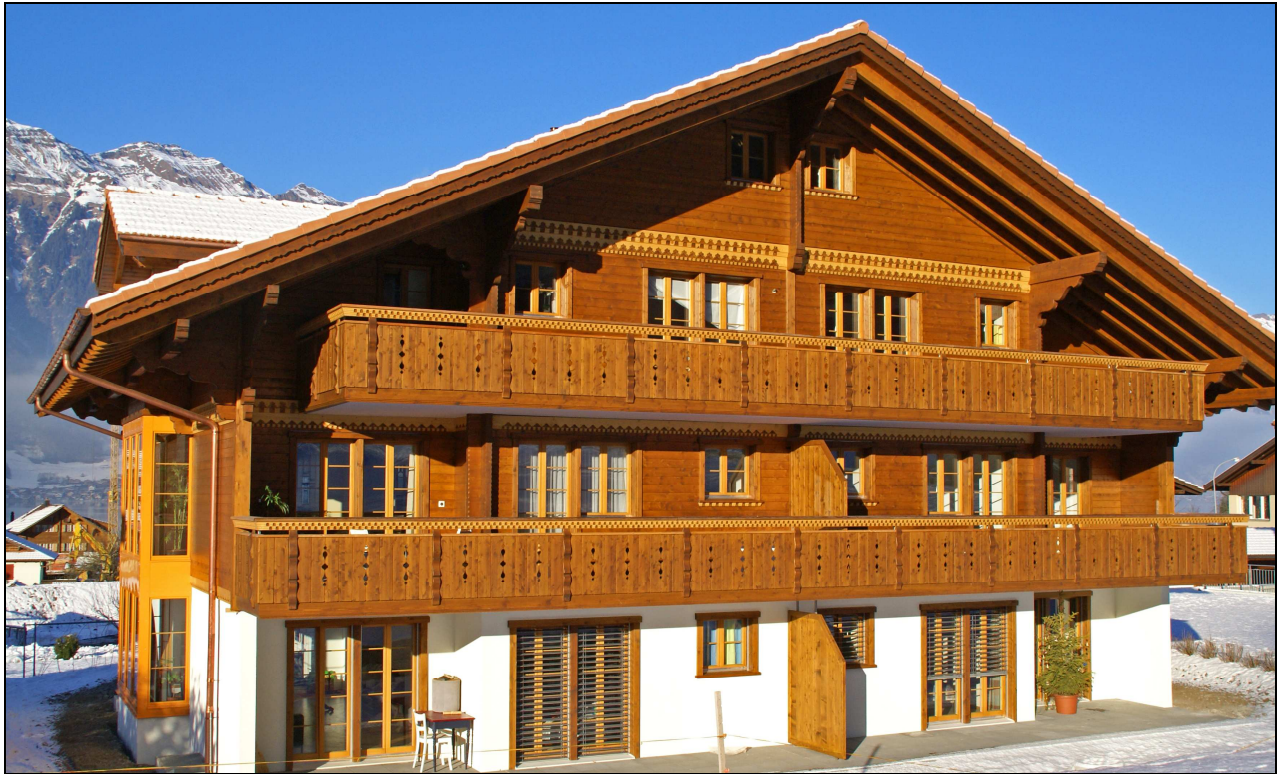
Referenzobjekt Chalet Faulhorn, Iseltwald
